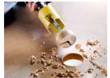
Einfaches Entfernen des Bohrkerns
